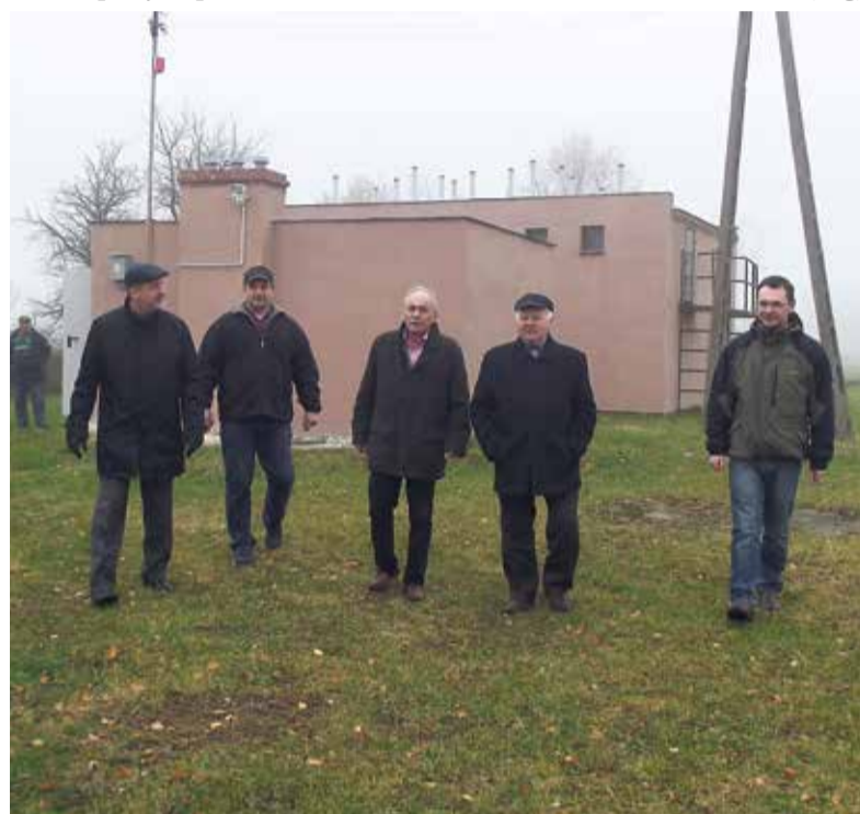
W Luszyńcu odnowiono oczyszczalnię ścieków
