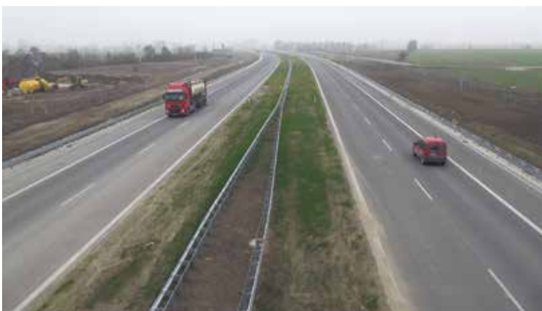
Na zdjęciu nowa autostrada przebiegająca w pobliżu miejscowości Pomarzanek
